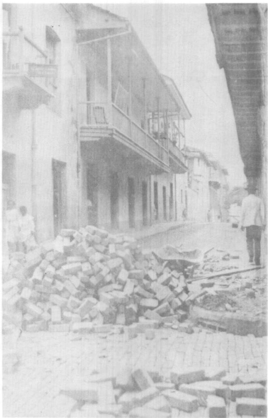
Pavimentación de un tramo de La Avenida "B" en La Década de 1910
