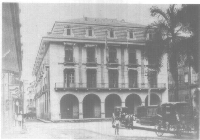
Edificio de Correos (1920 - 1924) reconstruido bajo la Administración del Presidente Porras contiguo edificio de las oficinas de la Compañía Universal del Canal Fránces.
