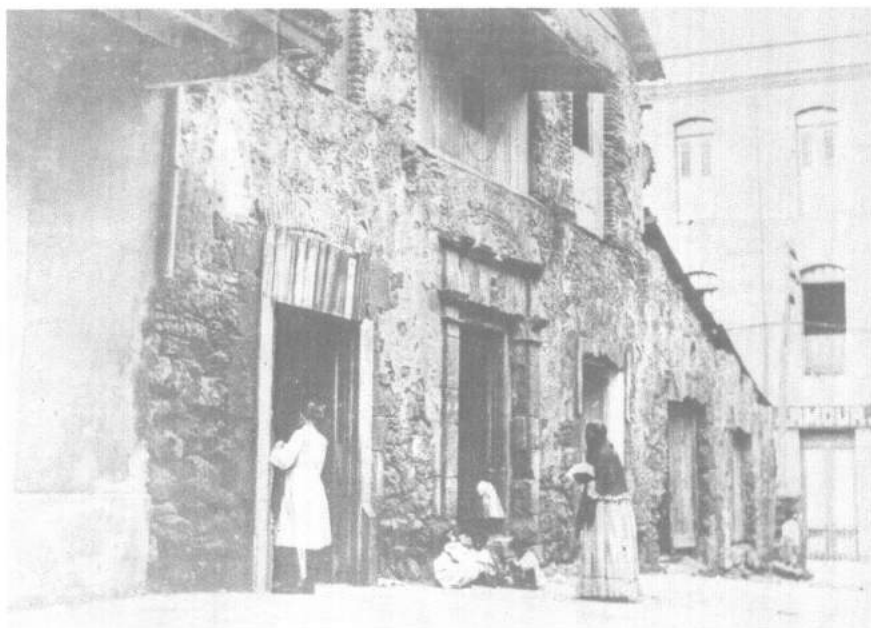
Antigua vivienda de Cal y Canto en un tramo de La Avenida "A" (finales de siglo XIX)
